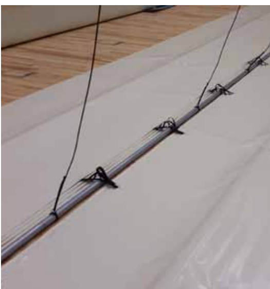
GIMNASTIČNI CENTER LJUBLJANA | IZVEDBA ŠIVANE ZAVESE NA OBJEKTU
